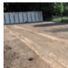
Dalle de dépôt des déchets verts avec système d'aération par soufflage intégré au sol
